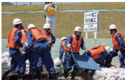
H27 東北水防技術競技大会 シート張り工、月の輪工
