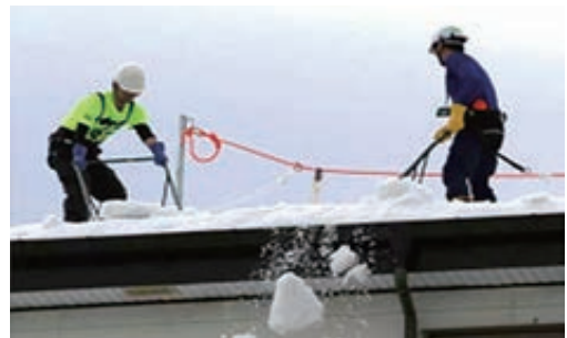
命綱、ヘルメットを装着して作業する様子(提供：新潟県)
