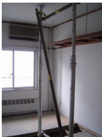
倒壊建物の安定化 (単管によるショアリング)
