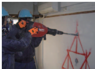
鉄筋コンクリート壁等の破壊訓練
