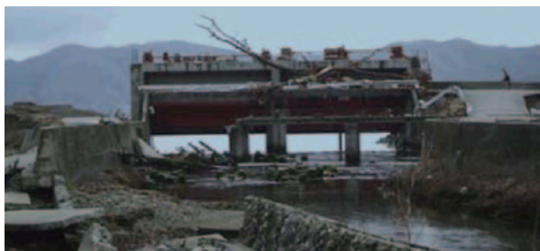
(津波により破壊された水門)
