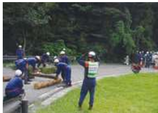
道路啓開訓練風景
