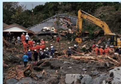
東京都伊豆大島土石流災害 (平成25年10月16日(水))
