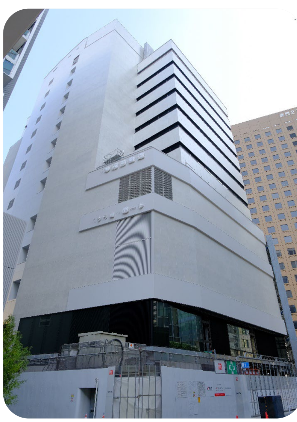
虎の門ヒルズステーションタワー側
