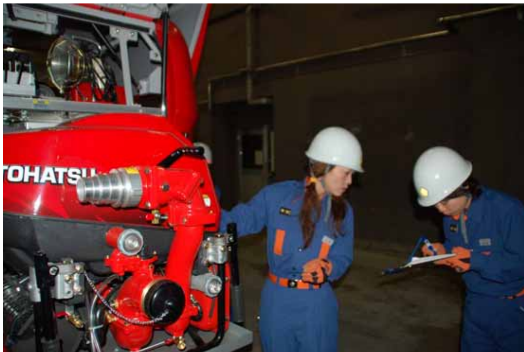
小型動力ポンプの作動状況確認の様子
